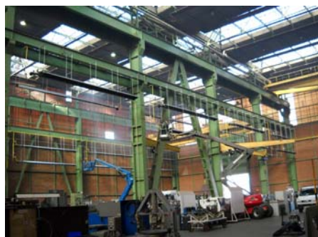
Tubes radiants gaz en "U", en ligne, en bandes ou en réseaux
